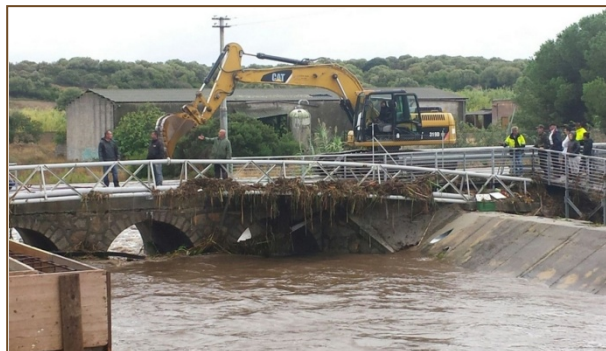
Foto 2.3.3 – Olbia: lavori di abbattimento del ponte sul Rio Siligheddu. Si noti la quantità di detriti deposti sul parapetto
